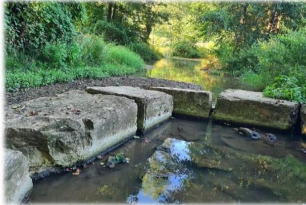
Einbringen abflussbremsender Strukturen
